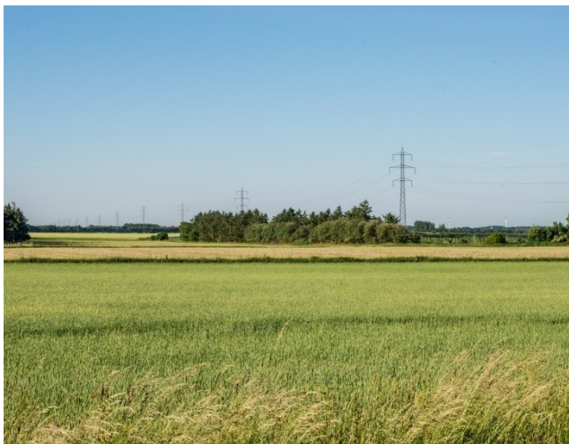
Figur 1 Nuværende 150 kV luftledning vest for Ølgod
